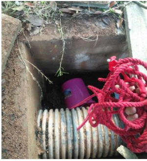
WW1 生活污水排放口
